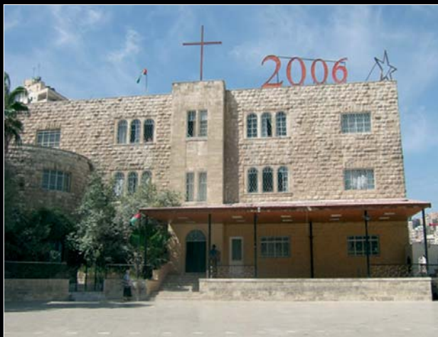
Die Rosenkranzschwestern von Aboud (Foto oben) in einem der renovierten Räume ihres Klosters. In Amman (Mitte und unten): Eingang der Kirche des Lateinischen Vikariats und Ansicht der Pfarrkirche vom Heiligsten Herzen.
