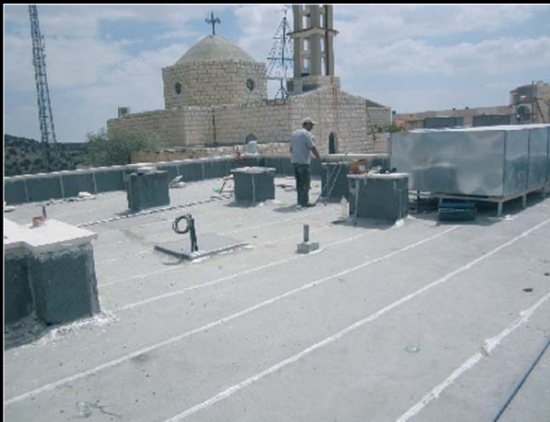
Ad Al-Hashimi e Al-Rusaifeh sono stati effettuati importanti restauri dei presbiteri (foto in alto e al centro) mentre ad Al-Wahadneh ne è stato costruito uno nuovo. Qui i lavori (in basso) sono ancora in corso sul tetto.
