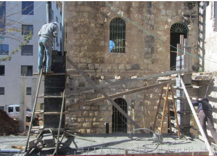
Bau einer Kinderkrippe in einer griechisch-katholischen Schule in Ramallah in Palästina.
