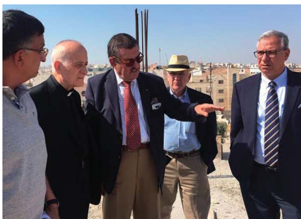
La delegazione del Gran Magistero e i rappresentanti del Patriarcato sul cantiere della chiesa di Jubeiha, nella periferia della capitale giordana, con l'architetto incaricato dei lavori.
